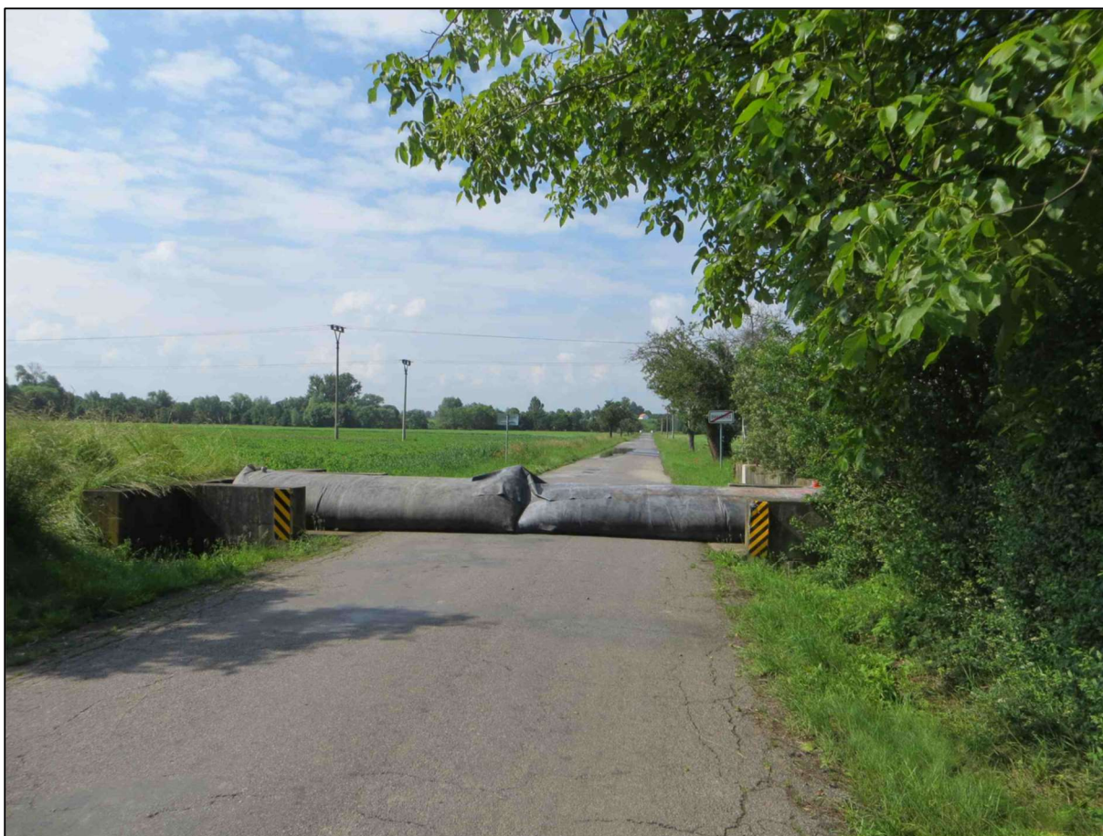
Obr. 1: Dvakačovice, stávající stav – celkový pohled vč. osazených gumových vaků (stav k 6/2020)
