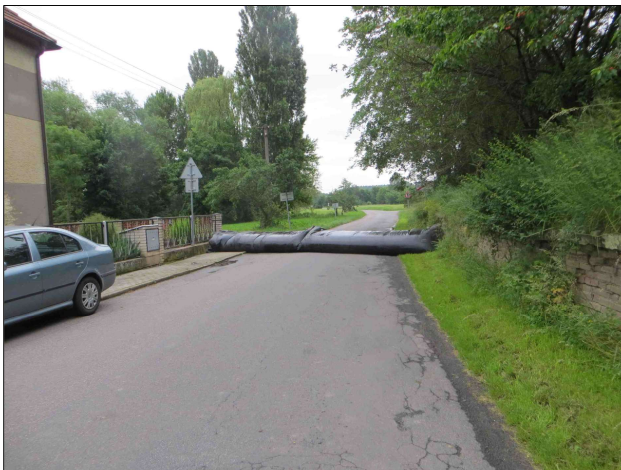
Obr. 4: Vejvanovice, stávající stav – celkový pohled vč. osazených gumových vaků (stav k 6/2020)
